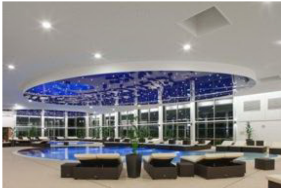
LaHydro auf einer solebeständigen Unterkonstruktion aus an Nonius-Hängern befestigten CD-Profilen sorgt als Akustikdecke für Stille rings um das Solebecken.
