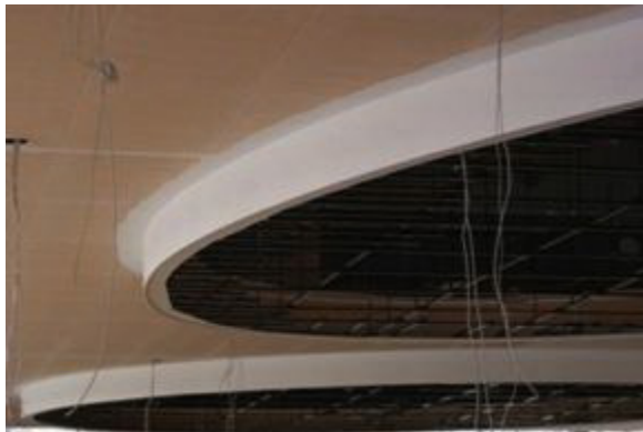
Von Siniat vorgefertigte 600 mm hohe Formteile bilden den passenden Rahmen für die Spanndecke über dem Solebecken.
