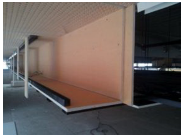
Hinter vorgefertigten Aufkantungen verläuft die indirekte Beleuchtung.
